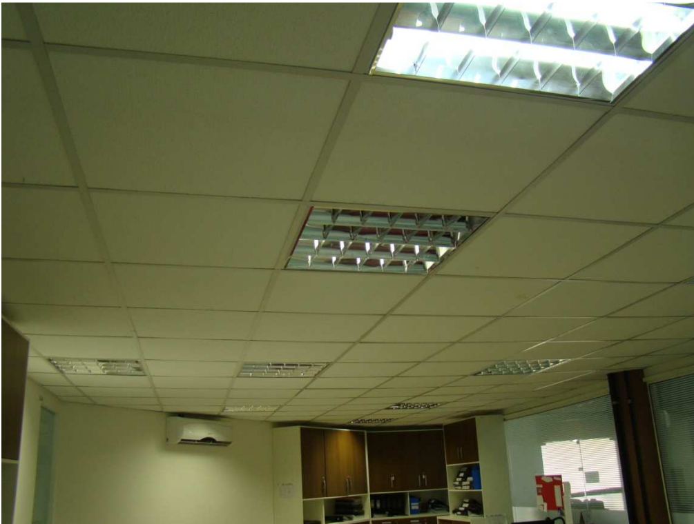
Foto 4 – Detalhe do forro
