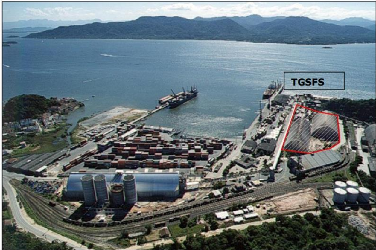
Figura 10 – Vista aérea do Porto de São Francisco do Sul com destaque para o TGSFS.
