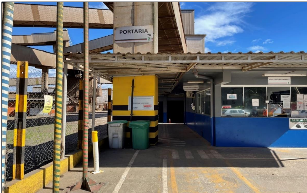
Figura 18 – Portaria do terminal.
