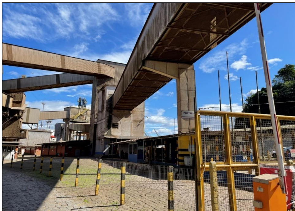
Figura 13 – Encontro: Galerias de estrutura metálica. Fonte: NCA Engenharia, Arquitetura e Meio Ambiente.
