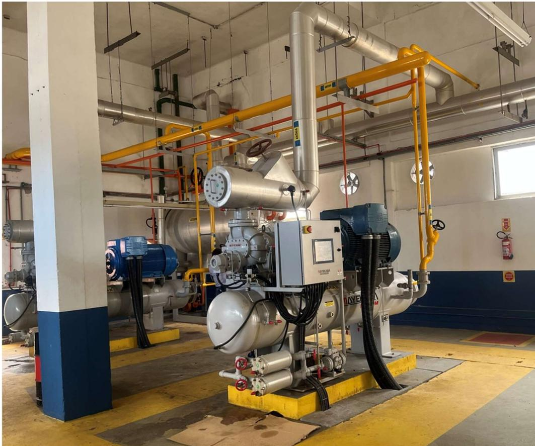
*Figura 13 – Gerador, condensador e compressor*
