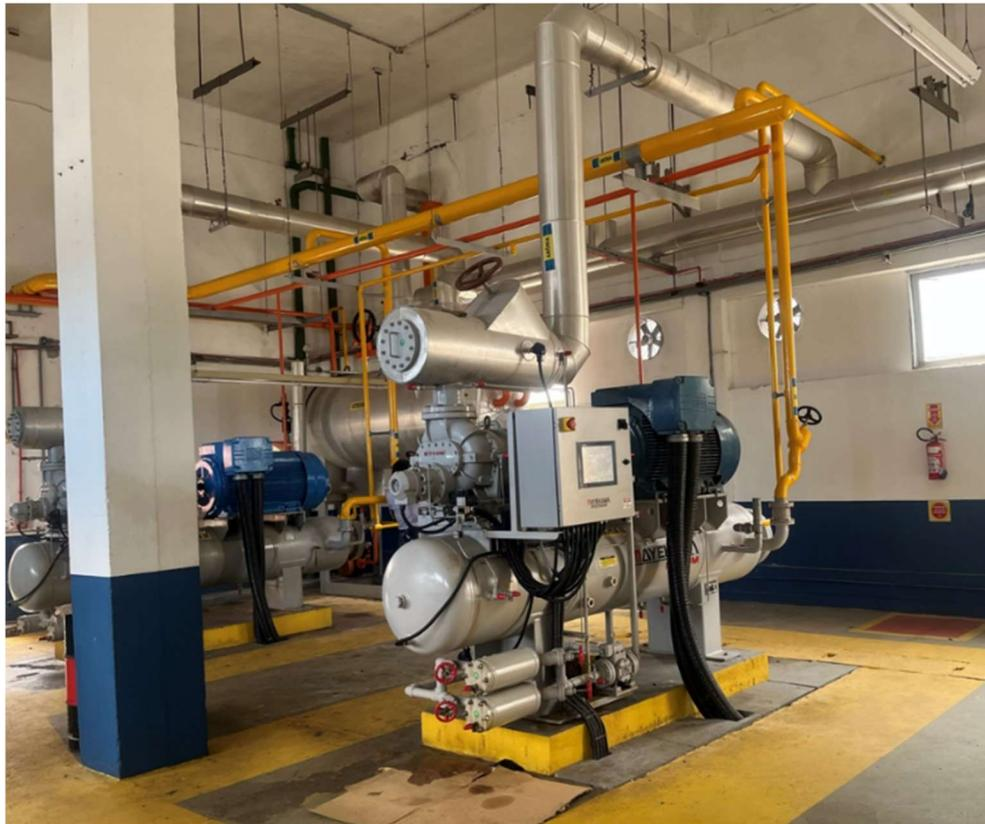
*Figura 11 - Gerador, Condensador e Compressor*
