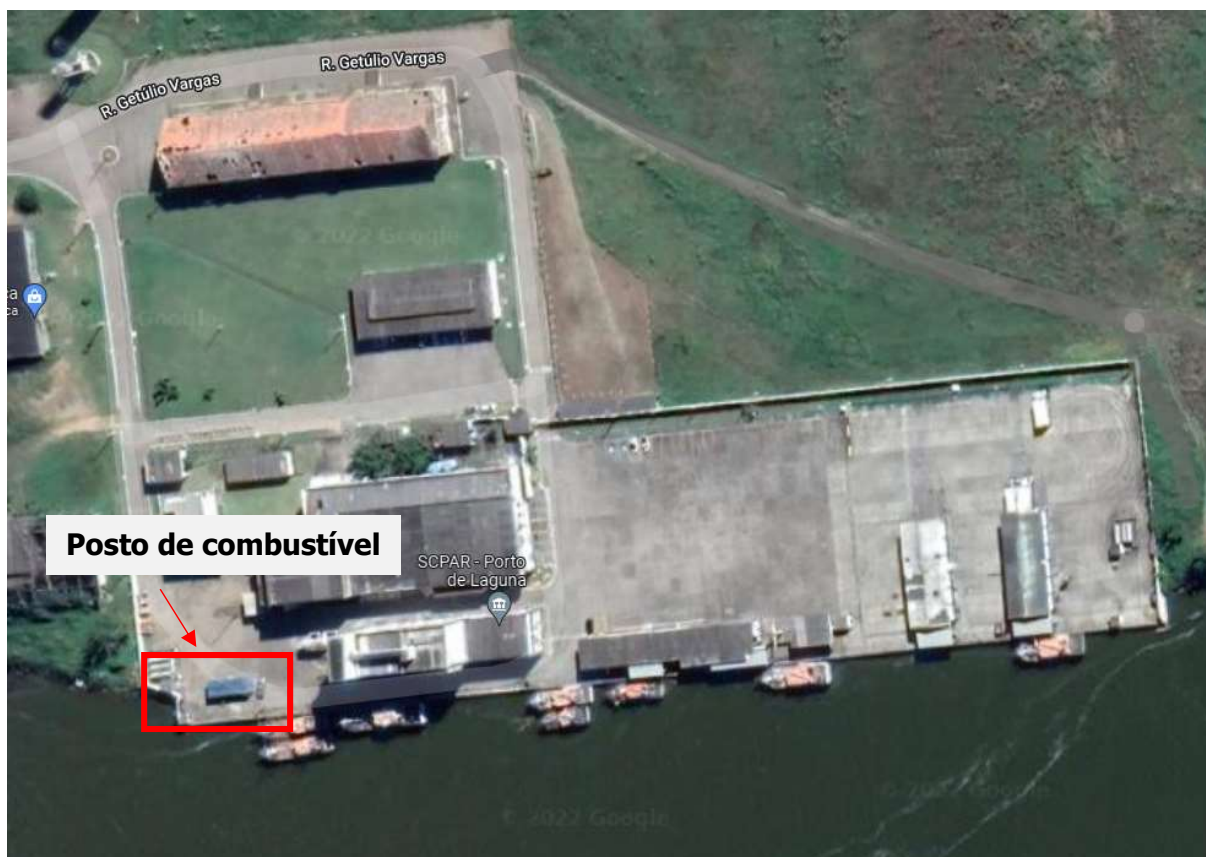
Figura 3 – Localização do posto de combustível do Porto de Laguna
