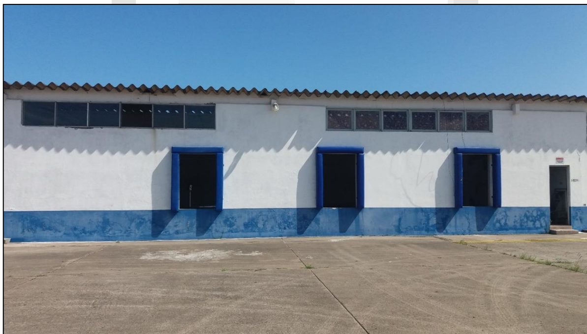
Figura 8: Detalhe das docas nos galpões 1 e 2
