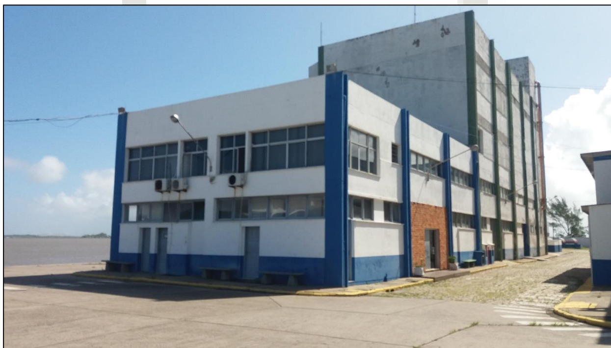
Figura 3: Prédio administrativo (estrutura com detalhes verticais na cor Azul)
