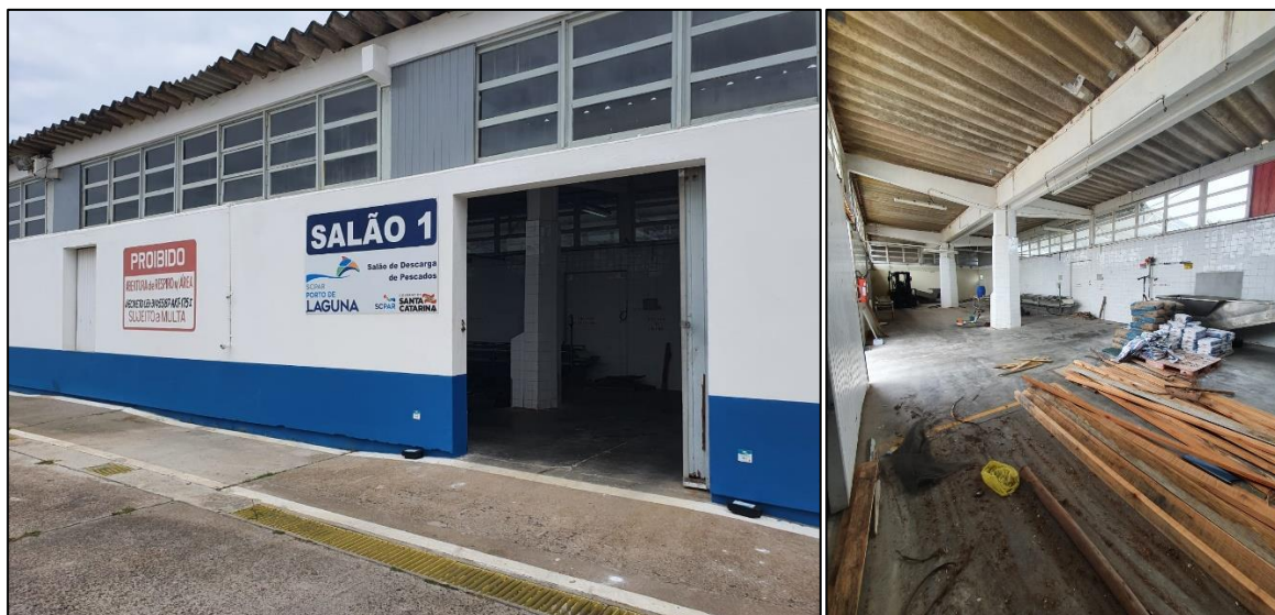
Figura 22. Salão 1 atualmente desativado e utilizado como Garagem.
