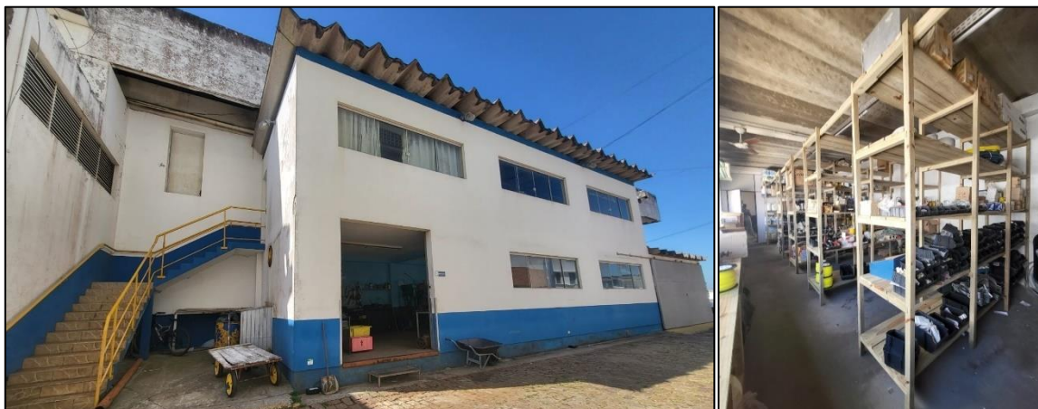
Figura 16. Almoxarifado do Porto de Laguna.
